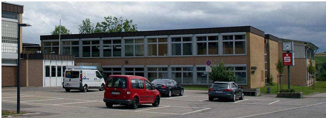
Außenansicht der Schule mit Technikraum BHKW
