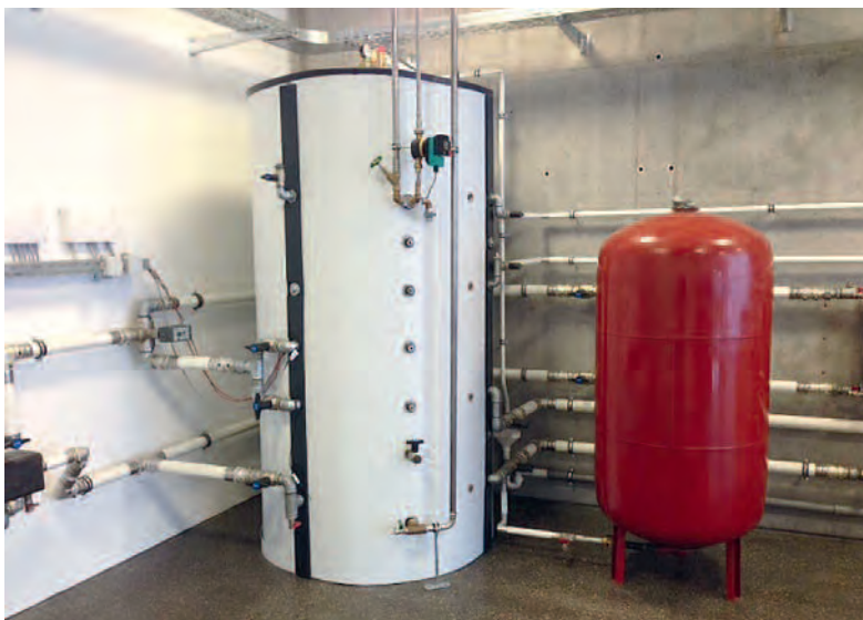
▲ Ein Hygienespeicher mit Edelstahl-Wellrohrwärmetauscher liefert im Durchlaufprinzip warmes Wasser.
