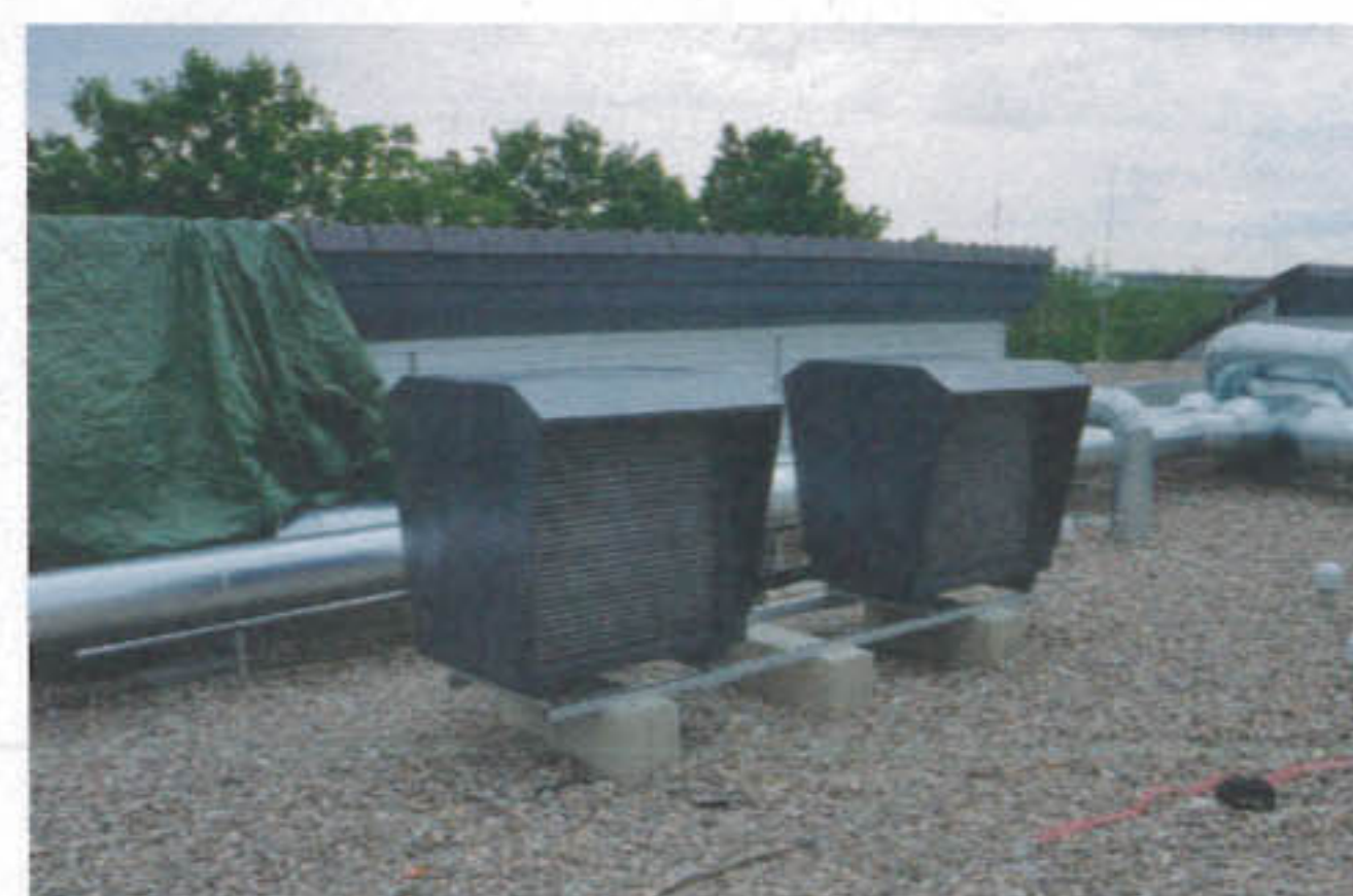
Die beiden Verdampfeinheiten der Luft-/Split-Wärmepumpe von Bartl auf dem Flachdach.
